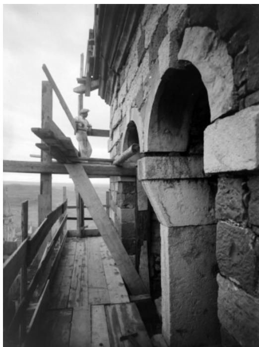
Lavori di restauro della cella campanaria a Buie in Istria nel 1931
