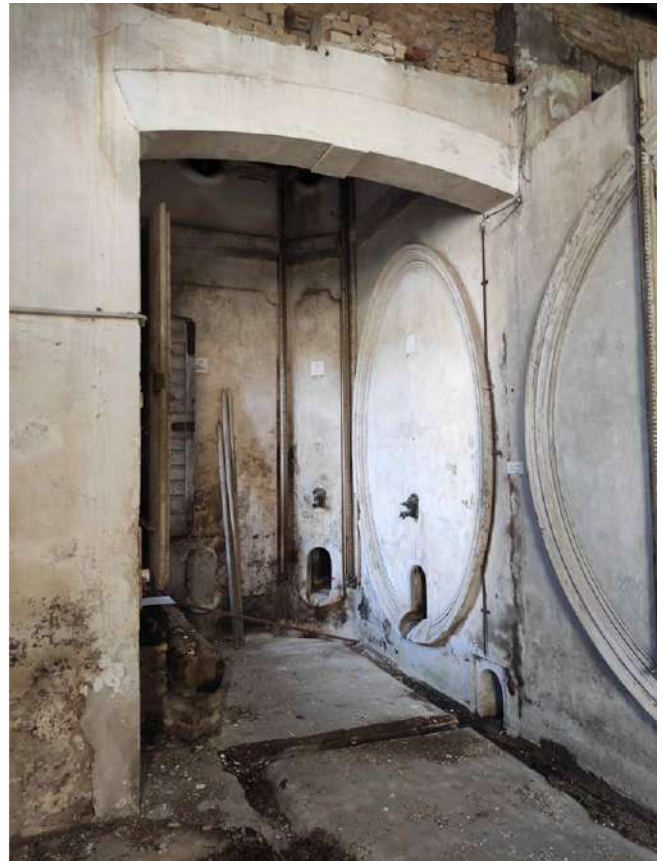
20-21_ le cisterne in cemento presenti nel vano nord del piano terra, di cui si prevede la conservazione
