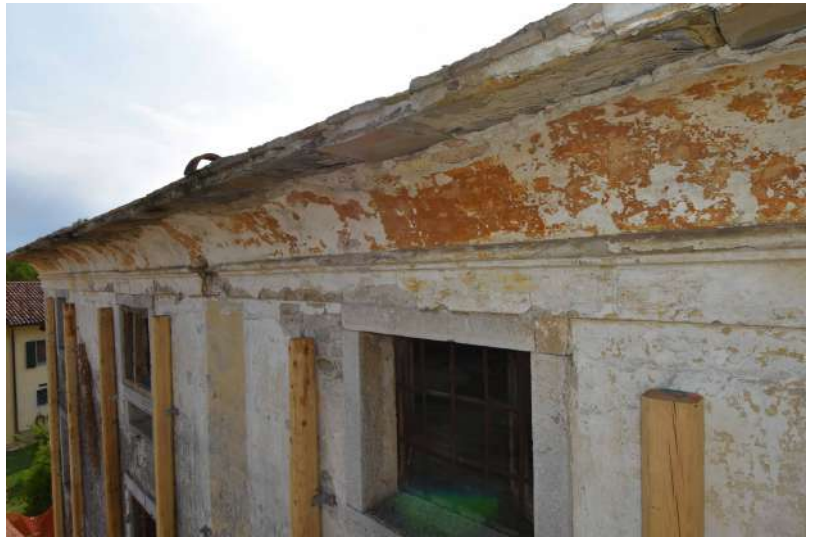
14-15_orditura secondaria di copertura prima della rimozione e messa in sicurezza del cornicione; il cornicione ora
