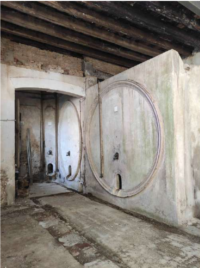
20-21_ le cisterne in cemento presenti nel vano nord del piano terra, di cui si prevede la conservazione
