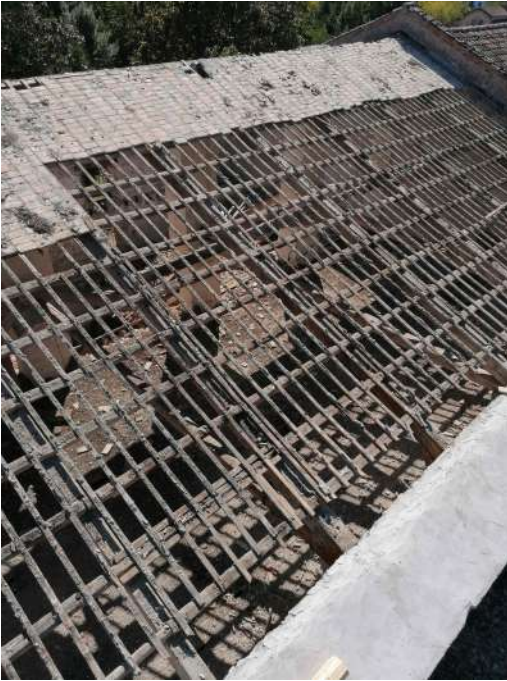
14-15_orditura secondaria di copertura prima della rimozione e messa in sicurezza del cornicione; il cornicione ora
