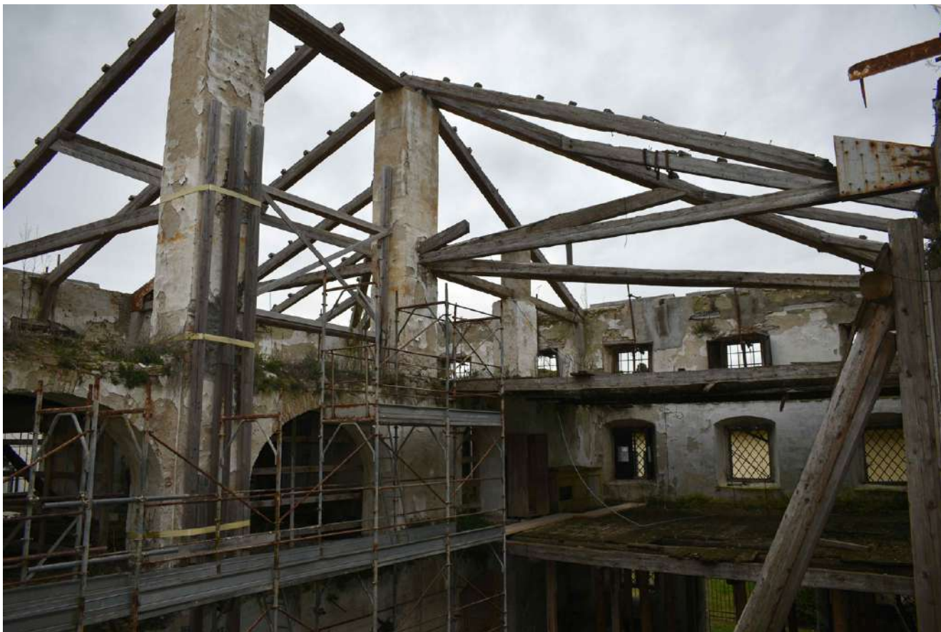
10_interno dal vano sud, primo piano: il muro centrale di spina, con la sequenza di archi e i pilastri superstiti
