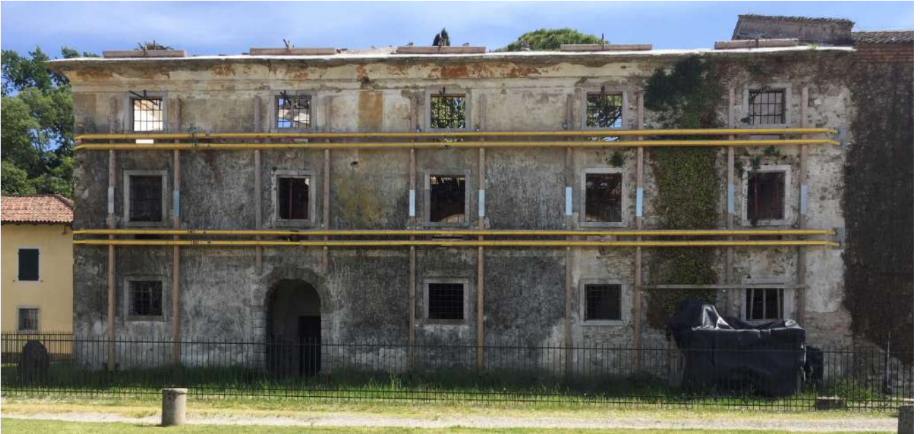
22_la facciata nord
