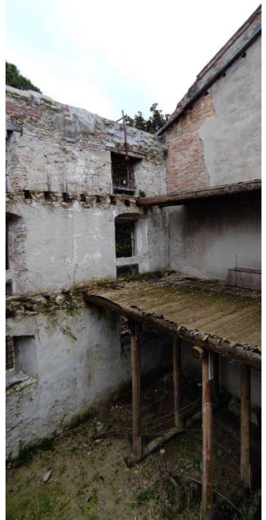
17_interno dello spigolo sud-ovest
