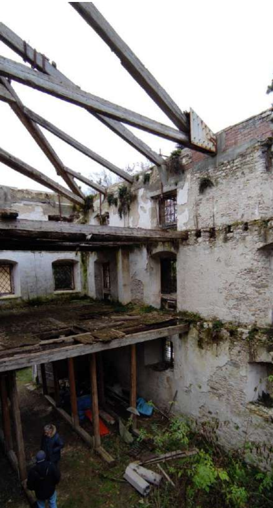
16_interno dello spigolo sud-est nello stato attuale
