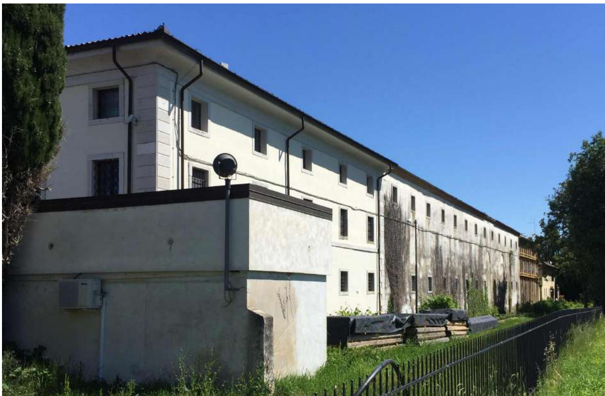
30_percorso di accesso al cantiere, lungo la facciata meridionale del complesso museale
