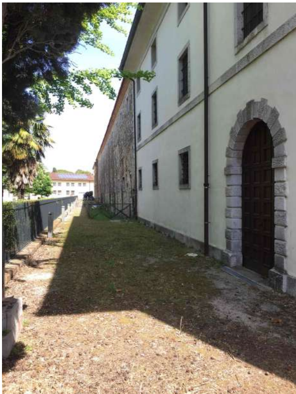
7_percorso di accesso nord all'ala est
